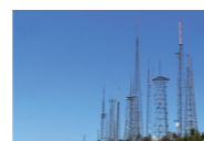
通信・電力設備
